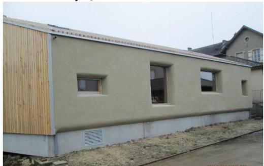
Finition sur béton de chanvre en plâtre et chaux recoupé
