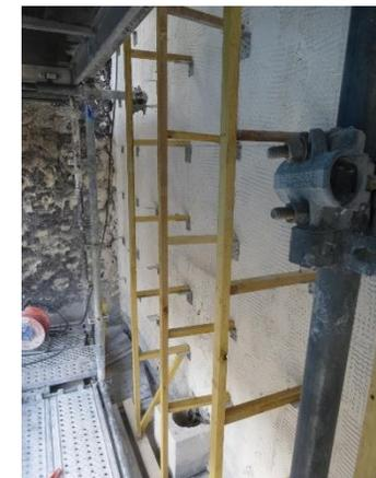
*Préparation du Support (pans de bois neufs, résines, confortation des maçonneries au plâtre, ossature bois pour le chanvre)*
